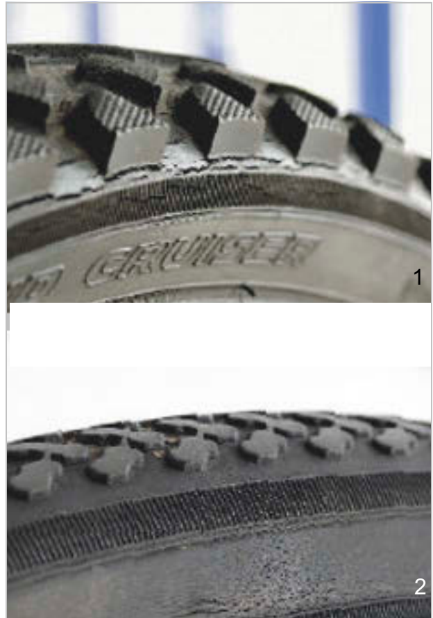
Obr. 199: Příklady únavových trhlin (1) a trhlin vzniklých stárnutím (2)
